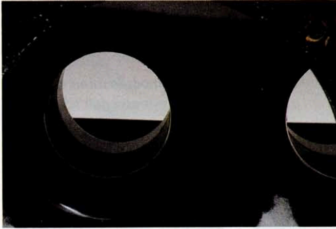
I due condotti interni sono realizzati con raccordi in PVC e tubo in cartone molto rigido e sordo. Da notare le svasure, sia interne che esterne.
